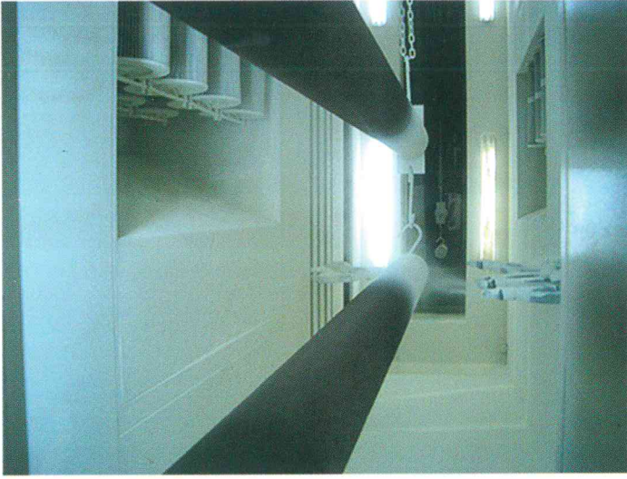
Çelik Konstriksiyon Boyama Tesisleri Steel Constriction Painting Lines
